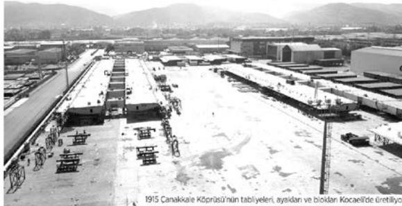
1915 Çanakkale Köprüsü'nün tabliyeleri, ayakları ve blokları Kocaeli'de üretiliyor.
